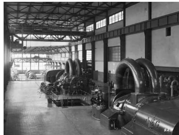
16 Blick in die Maschinenhäuser. Im Vordergrund die beiden 37,5 MVA / 27,5 MW Kondensationsturbosätze M1 und M2. Im Hintergrund das neue Maschinenhaus mit den beiden Vorschaltturbinen.
