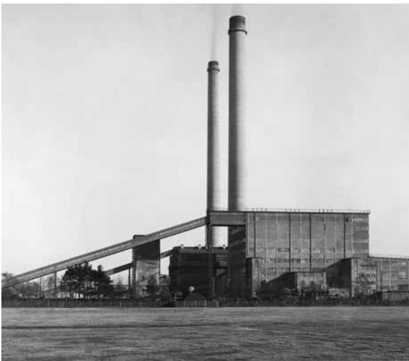
10 1929, zwischen den beiden Kaminen, die bereits 2/3 ihrer Höhe von 140 m erreicht haben, wächst das Stahlskelett für das Maschinen- und Kesselhaus empor. Links die nahezu fertiggestellten Werksohnhäuser.
