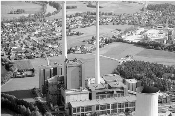
25 Dampfkraftwerk in seiner Endphase Block B, C und D, hinter dem Kühlturm das gemeinsame Maschinenhaus.
