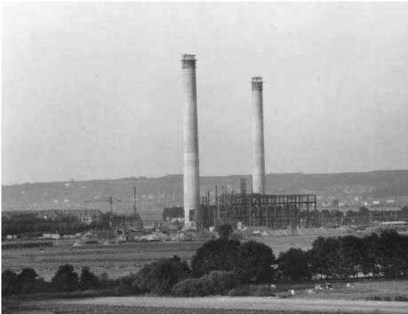
10 1929, zwischen den beiden Kaminen, die bereits 2/3 ihrer Höhe von 140 m erreicht haben, wächst das Stahlskelett für das Maschinen- und Kesselhaus empor. Links die nahezu fertiggestellten Werksohnhäuser.
