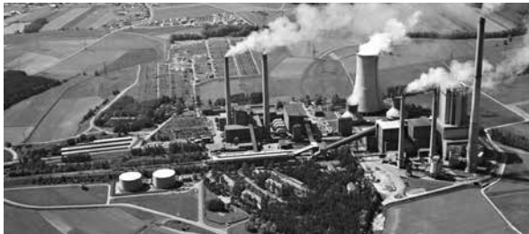
2 1970 zwei Jahre vor der Eingemeindung nach Schwandorf, von links das alte Sammelschienen-Kraftwerk, Block A, B, C und D. In diesem Zustand hatte das Kraftwerk eine Leistung von knapp 900 MVA.
