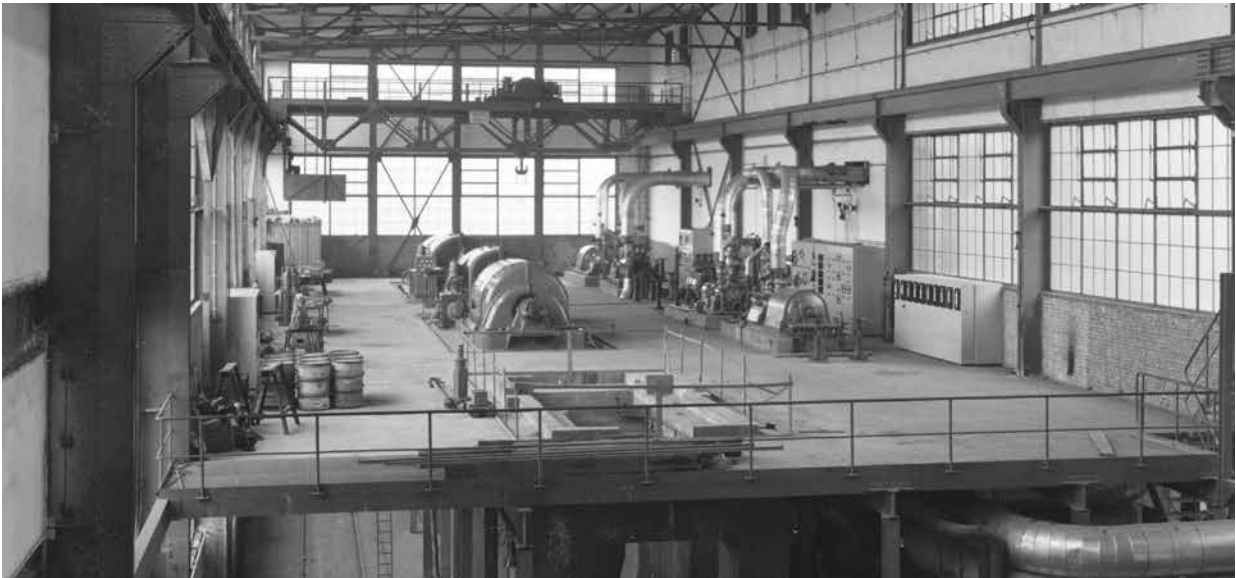
17 Blick in das neue Maschinenhaus mit den beiden 11,4 MW Vorschaltturbogruppen. Davor das Fundament für die 6,4 MW Hausturbine. Im Vordergrund die für beide Maschinenhäuser gemeinsame Montageöffnung mit dem Platz für einen weiteren Turbogenerator. Längs der rechten Seitenwand sind die Speisepumpen für die HD-Kessel aufgestellt. In der Mitte zwei Dampfturbopumpen für 250 t/h vorne und hinten je eine Elektrospeisepumpe für 125 t/h.
