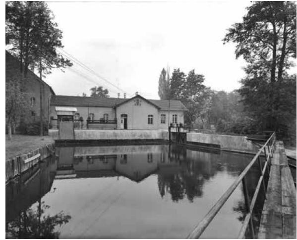
Kraftwerksanlage Ettmannsdorf, von links altes Mühlengebäude mit Dieselmotorkraftwerk, querstehendes Wasserkraftwerk, mit Einlauf und Rechenreinigungsmaschine und rechts der Leerschluß.
