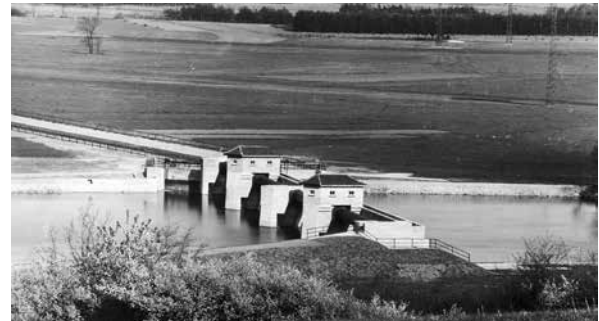
13 Stauwehr, das die Naab 70 cm aufstaut, um für genügend Kühlwasser zu sorgen
