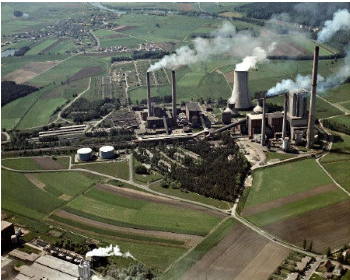
Braunkohlekraftwerk in Dachelhofen, 1972 voll ausgebaut mit 893 MVA / 703MW. Rechts die Naab einschließlich Ein- und Auslauf und die 3 Kühltürme die das Kraftwerk mit Kühlwasser versorgen.
